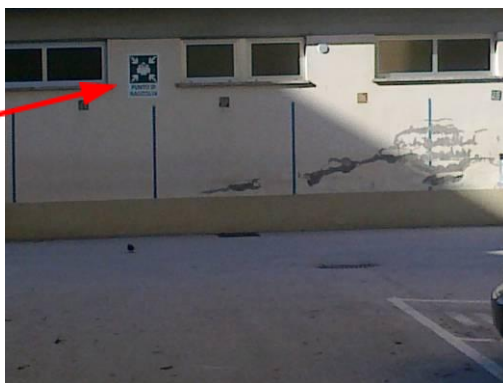
Foto 5: punto di raccolta esterno
