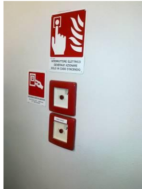
Foto 1: piano rialzato vano scala sud-est
