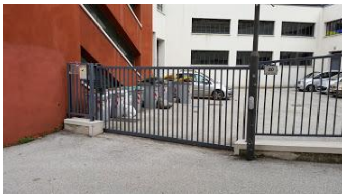
Foto 4: accesso utenti esterni palestra e accesso automezzi da Via Torre d'Augusto.
